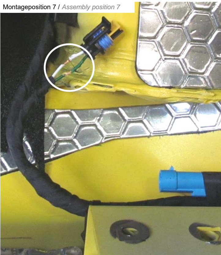
Isolierung des Kabels entfernen.
